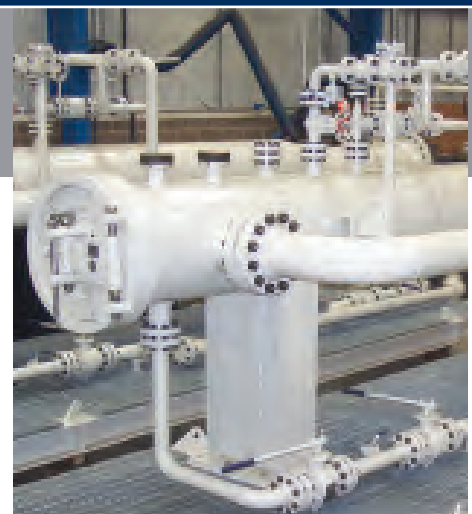
Камера запуска с быстрооткрывающейся торцевой крышкой
