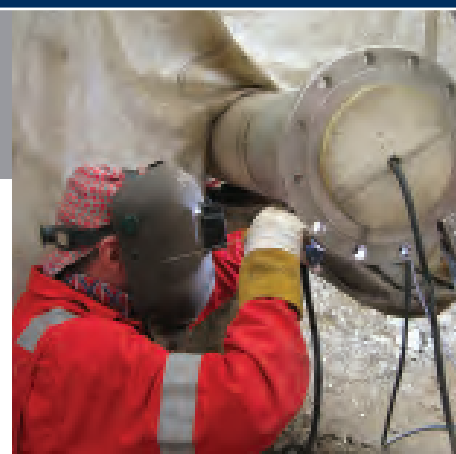
Сварка на месте
